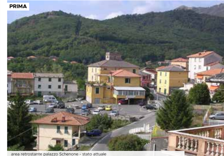
area retrostante palazzo Schenone - stato attuale
