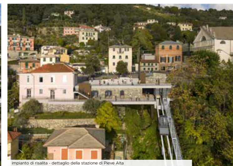
impianto di risalita - dettaglio della stazione di Pieve Alta
