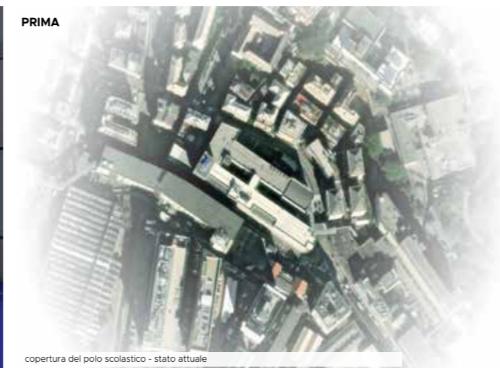
copertura del polo scolastico - stato attuale
