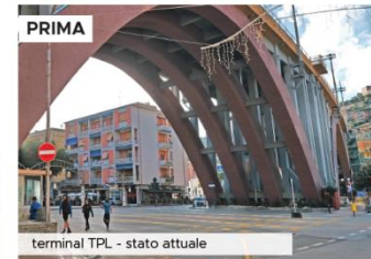
terminal TPL - stato attuale
